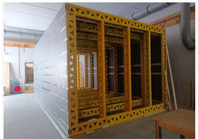
Fig.4: Chambre amagnétique en construction / Magnetische afschermdende kamer onder constructie (08/2024)
