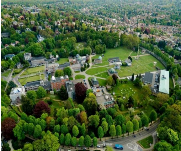
Photo 2. Aperçu du site d'Uccle vu du ciel
